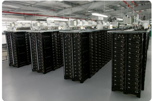
Blick auf die Lithium-Ionen-Zellen im Inneren des Krftwerks
