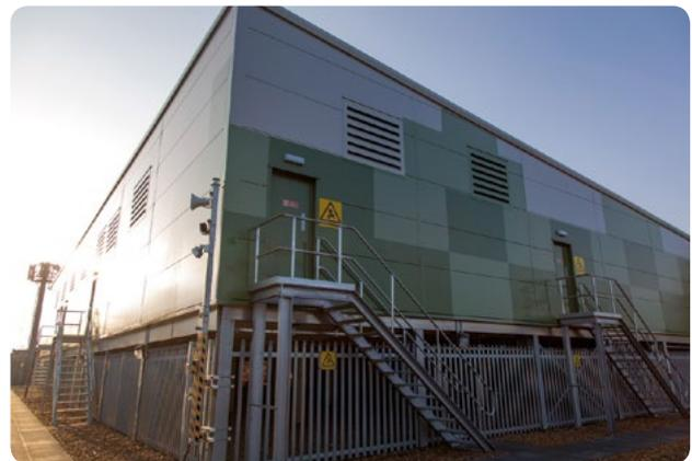
Smarter Network Storage: Batteriekraftwerk am Umspannwerk in Leighton Buzzard
