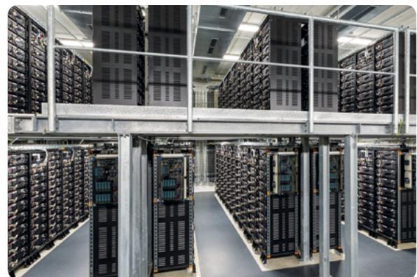
Batteriepark von innen: In den insgesamt 1.600 Trays verbergen sich 25.600 Lithium-Manganoxid-Zellen
