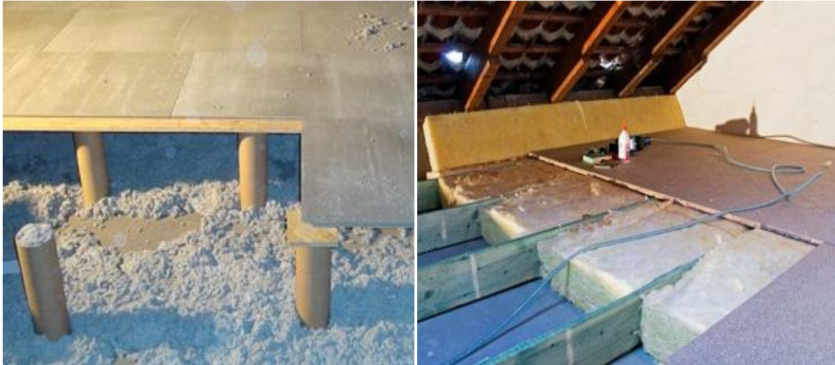
Abbildung 6-22: Varianten der Dämmung der obersten Geschossdecke: Einblasdämmung (links, Quelle: InnoDämm - Vertriebsgesellschaft für innovative Dämmstoffe, 2013), Matten (rechts, Quelle: ARCHmatic, 2013)
