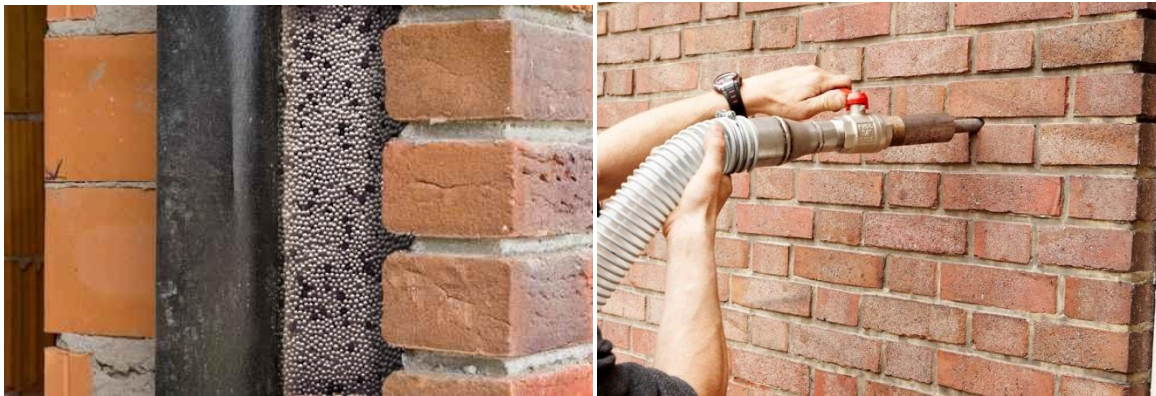
Abbildung 6-21: Dämmschicht zwischen Außen- und Innenwand (links, Quelle: Ökologische Baustoffe Bielefeld, 2013), Einblasen des Dämmstoffes (rechts, Quelle: KaSaTech, 2013)
