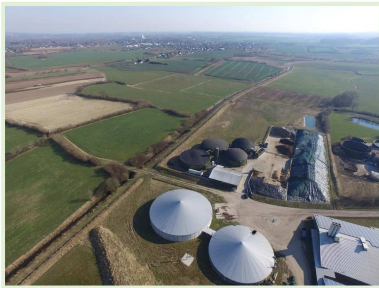
Biogasanlage in Satrup von Norden - Richtung Süden (Quelle: BIOGAS Hof Obdrup)
