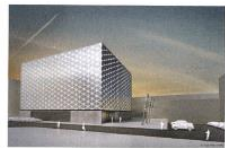
Neben den klassischen Optionen wie Nass- oder Trockenkühler und Hybridlösungen testen insbesondere internationale Konzerne derzeit verstärkt neue Systeme zur effizienten Nutzung erneuerbarer Energien für die Kühlung ihrer Rechenzentren.
