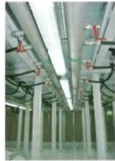
Abb. 1: Ansicht der Stahlskelettkonstruktion des MiniCube beim Heimlab-Rechenzentrum für Schwärmerforschung (GSI), Darmstadt.
